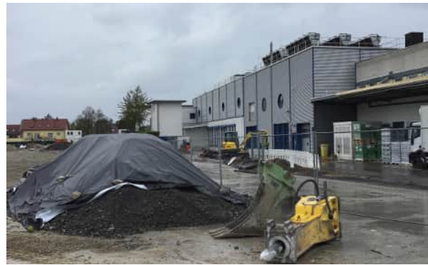
Blick von Abbruchfläche auf mittleren Teil des südlichen Produktionsgebäude im Planungsgebiet
