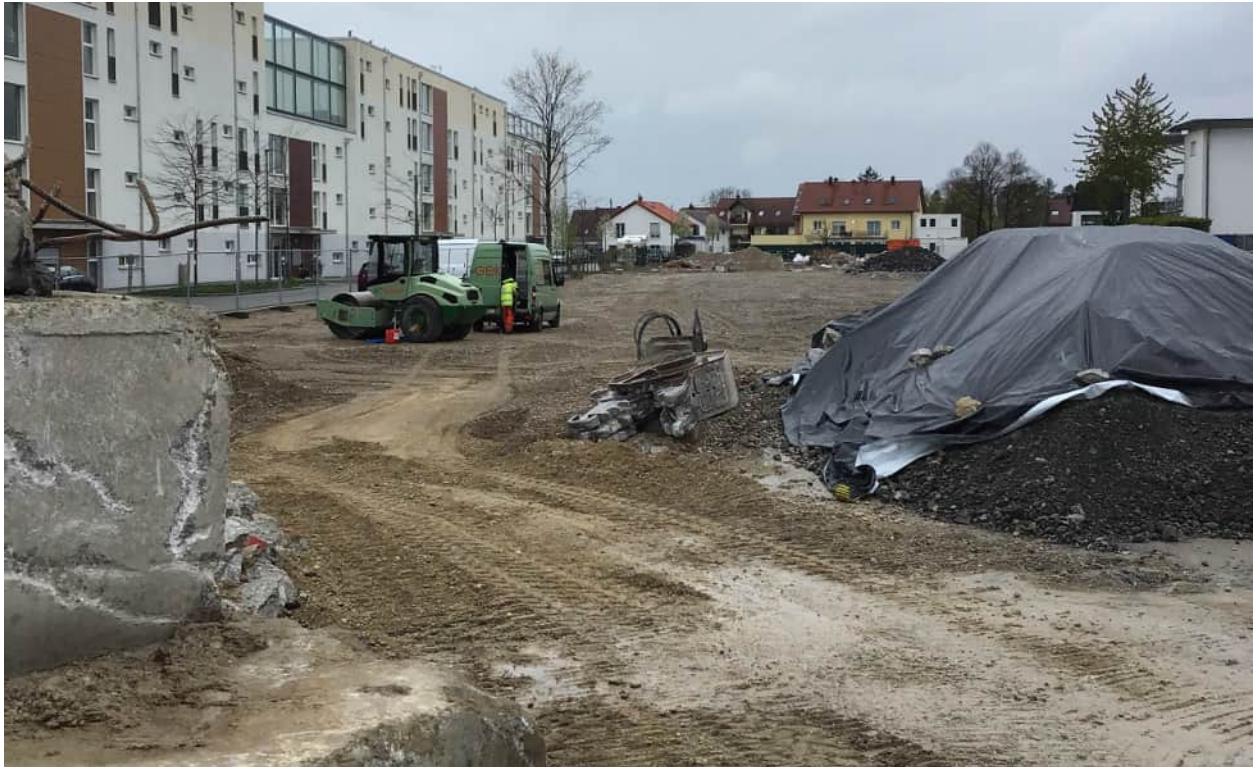
Abbildung 2: Fläche im Westen des Planungsgebiets, auf der die Bestandsgebäude abgerissen wurden
