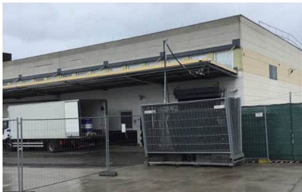
Südlicher Teil des Produktionsgebäudes im Süden des Planungsgebiets
